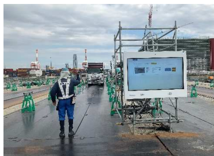
【予定情報に基づく現場ゲートの入場管理の様子】
